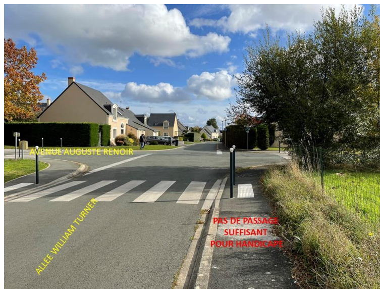
Allée William Turner : passage insuffisant pour poussette ou fauteuil roulant
