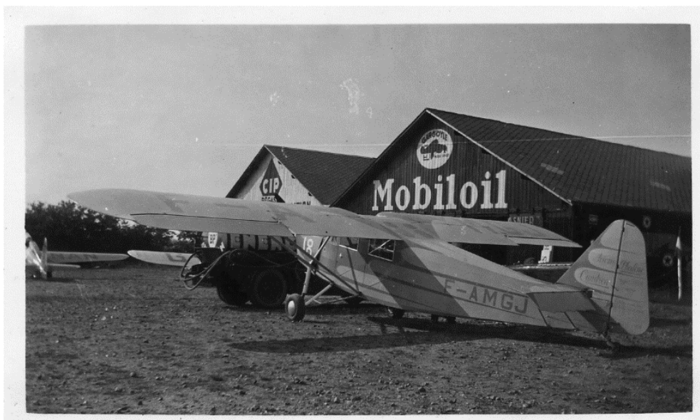
Aérodrome d'Avrillé 1933, hangar Tourisme (photo source Ch. Ravel)
