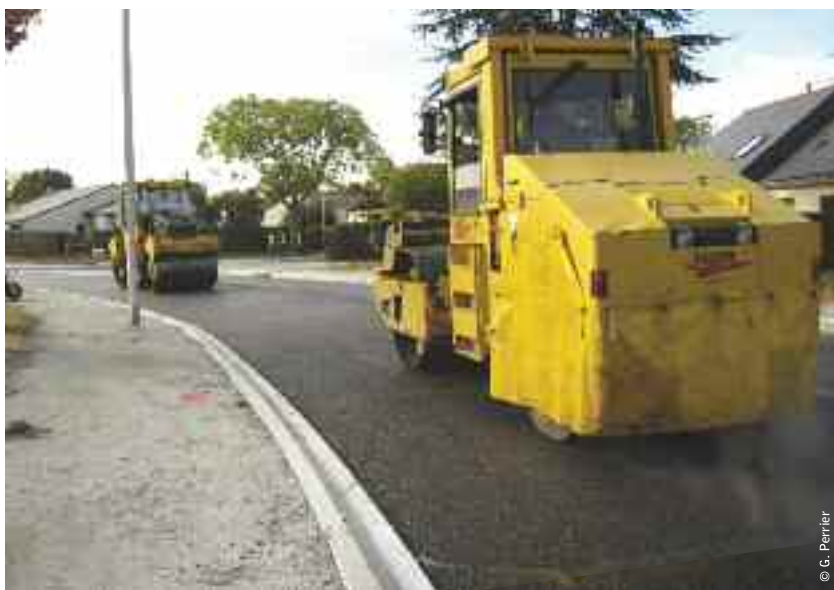
La pose du nouveau revêtement ne dégage que très peu de fumée.
